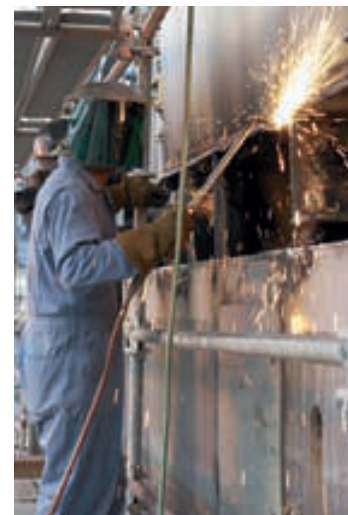
▲ Corte de acero utilizando un soplete oxiacetilénico.
